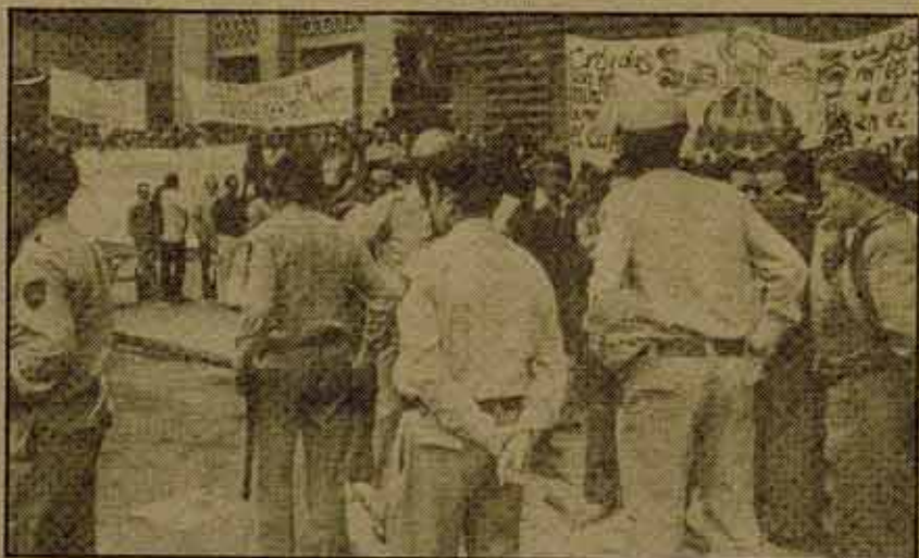
En sus numerosas manifestaciones ante el edificio del MOPU, los vecinos de los barrios afectados se han tenido que enfrentar a la actuación de la policía. Esta vez no fue la excepción y la policía les obligó a desalojar después de que el secretario del ministro se negase a recoger un escrito de los vecinos.
