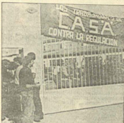
Los trabajadores en una de las puertas de la fábrica.
