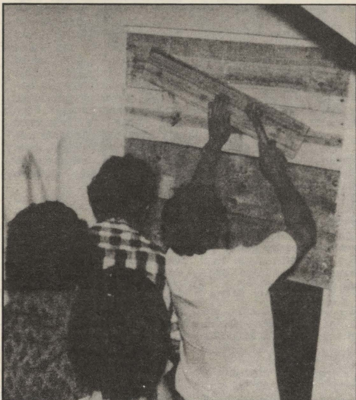
Vecinos de Lezo tapiando pisos de traficantes
